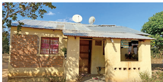
送電はないが、ソーラーパネルと衛星放送のアンテナを持つ農村の住居
