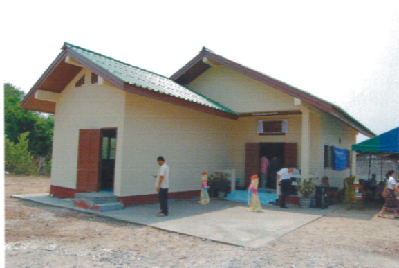
建設された野田教授メモリアル研修センター
