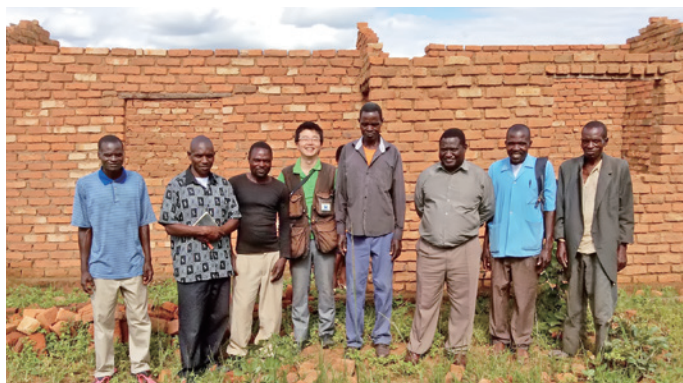
建設中の建物を視察
